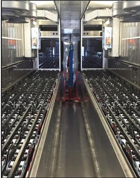
**Abbildung 6-11:** Modulare Blei-Säure-Batterieeinheit, Alt Daber, Deutschland
