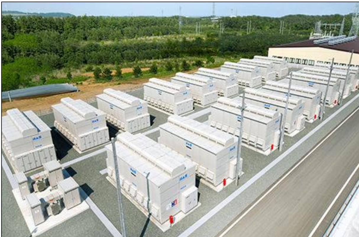
**Abbildung 6-24:** Modulare Natrium-Schwefel-Batterieeinheiten, Windkraftanlage, Futamata, Japan
