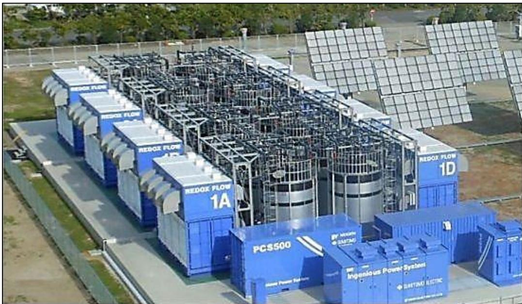
**Abbildung 6-29:** Modulare Redox-Flow-Vanadium-Batterieeinheiten, Solarkraftwerk, Abira, Japan
