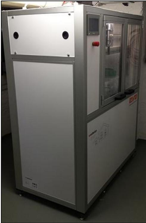
**Abbildung 6-31:** Redox-Flow-Vanadium-Batterie für haustechnische Anlagen
