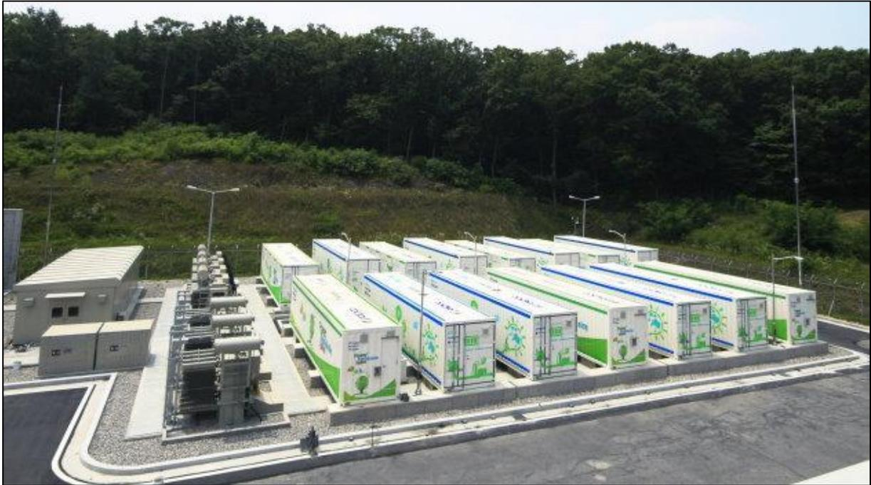
**Abbildung 6-19:** Lithium-Nickel-Mangan-Kobaltoxid Energiespeichersysteme zur Netzmoderation, Non-Gong, Südkorea
