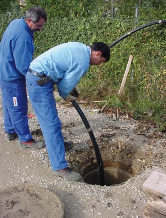
Abb. 13: Herstellung eines Energiebrunnens
