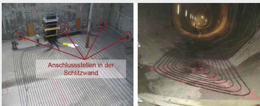
Abb. 7: Energiebodenplatten in einem Stationsbauwerk (links) und in einem Tunnelabschnitt (rechts) bei der U-Bahnlinie U2 in Wien.
