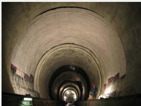
Abb. 9: Einbau des Energievlieses im bergmännischen Tunnelbau beim Lainzer Tunnel Bauabschnitt „LT22 – Bierhäuselberg“
