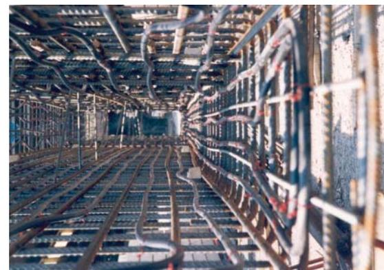
Abb. 3: HDPE-Absorberleitungen einer „Energieschlitzwand“, montiert am Bewehrungskorb eines Schlitzwandelementes
