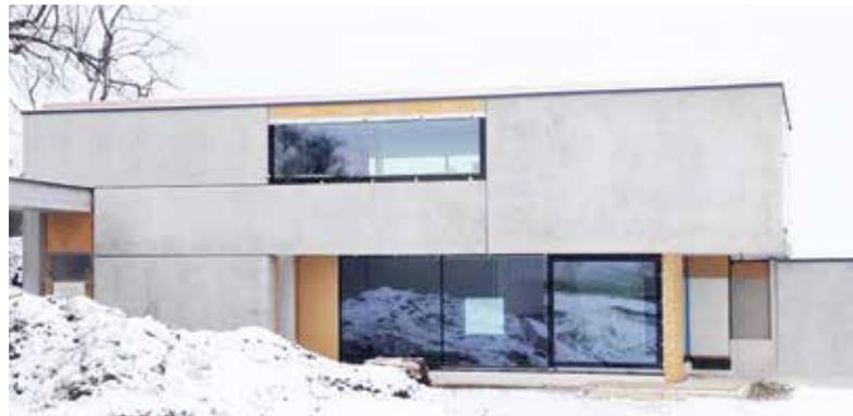
Durch die Einbettung von Heiz- und Kühlleitungen im Beton – man spricht von Bauteilaktivierung – wird der Baustoff zum thermischen Speicher, mit dem sich das Wohnklima regulieren lässt.
