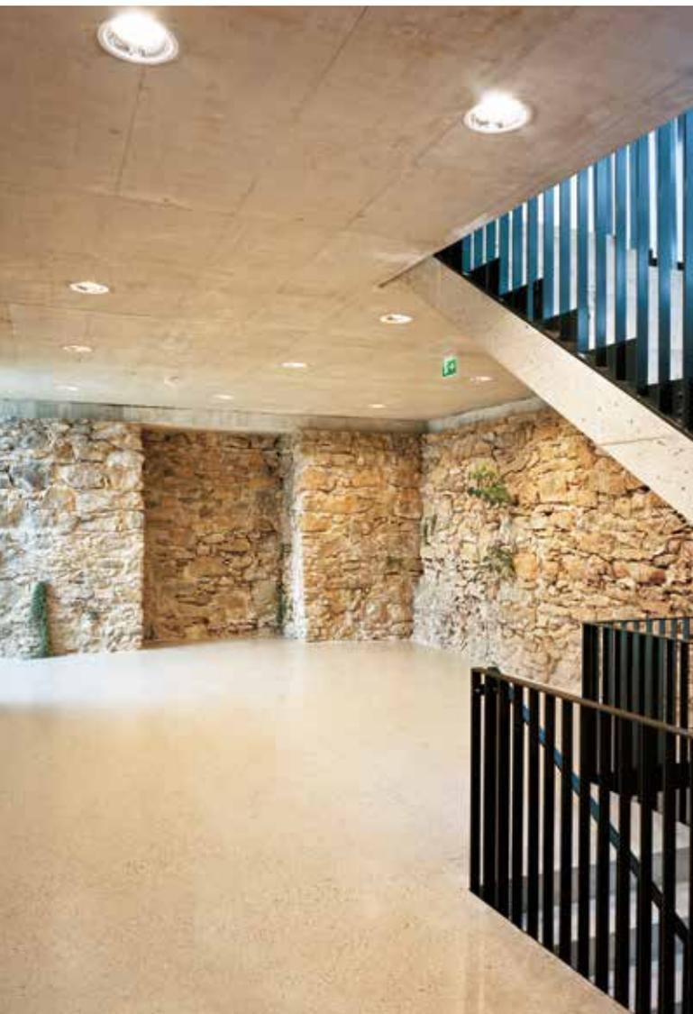
Die Wärmeabgabe in den neuen Bereichen erfolgt über aktivierte Sichtbeton-Deckenplatten, durch die ausreichend Wärmespeicher Masse gegeben ist. „Das Projekt hat vor allem durch seine intelligente Situierung, seine Ausformung und die funktionelle Gliederung des Baukörpers beeindruckt“, erläutert Manfred Schuller, Leiter des Stadtbauamts und Jurymitglied.
