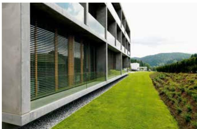
**Im Zentrum des Energiekonzepts standen die Reduktion von Kühllasten durch baulichen Sonnenschutz, Speichermassen des Betons, und vorrangig passive Kühlmaßnahmen in Kombination mit Nachtkühlung.**
