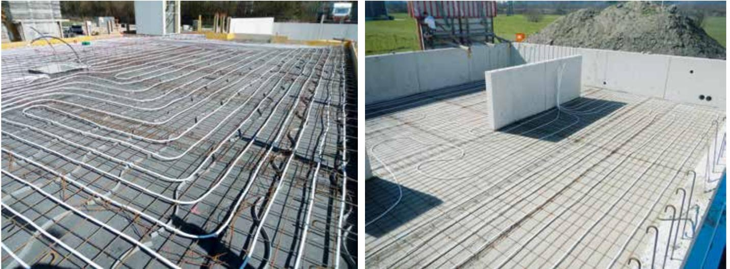
Leitungen in der Bodenplatte bzw. im Erdspeicher – Wärmeenergie wird ohne Wärmetauscher direkt in den Betonkern geleitet und gespeichert.
