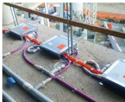
Elektro- und Heiz-Kühlrohre über Rohdecke
