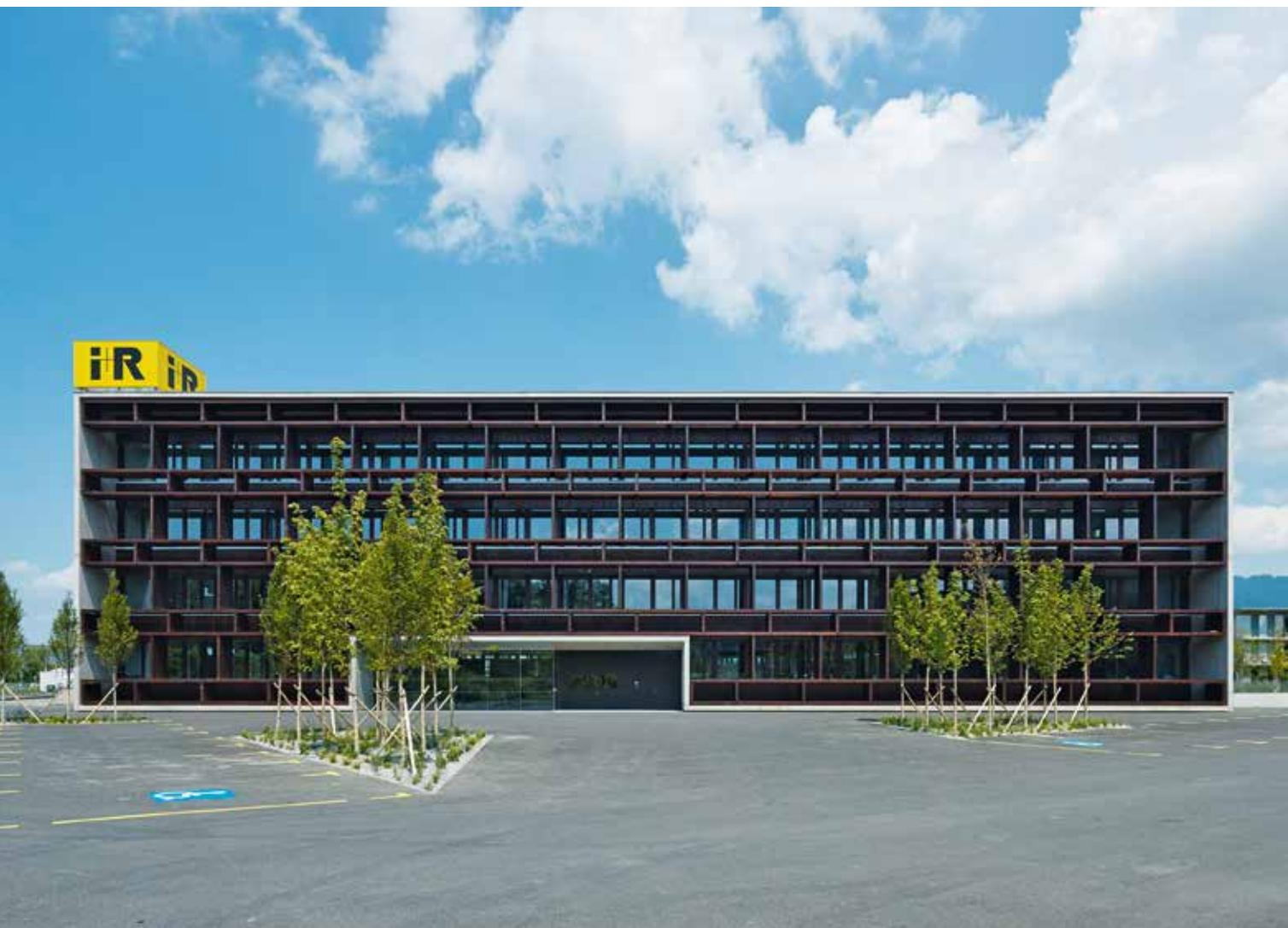
Von Beginn an wurde bei der Konzeption des Gebäudes darauf geachtet, dass firmeneigene Produkte wie Beton, Holz und Holzfenster sichtbar und gestaltprägend eingesetzt werden konnten. Beton für statische Bauteile sowie sichtbare Wandscheiben im Innen- und Außenraum, Holz für die ausfachende Konstruktion und Bandfassaden mit Holzfenstern. Der Entwurf kann damit als „Musterbau“ für die Arbeit und Qualität der i+R Gruppe stehen.
