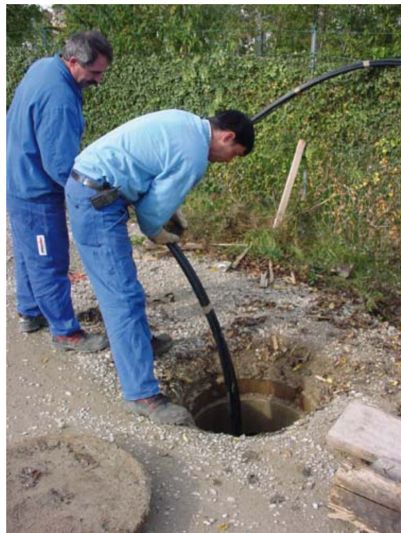
Abbildung 12: Herstellung eines Energiebrunnens
