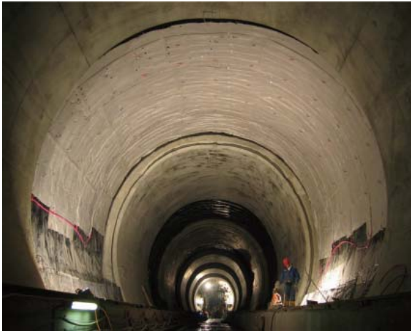
Abbildung 9: Einbau des Energievlieses im bergmännischen Tunnelbau beim Lainzer Tunnel Bauabschnitt „LT22 – Bierhäuselberg“
