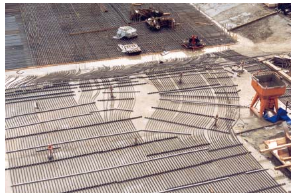
Abbildung 1: HDPE-Absorberleitungen einer „Energiebodenplatte“, montiert auf der Sauberkeitsschicht eines Hochbaus
