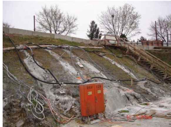
Abbildung 11: Energieanker-Testanlage in einer Böschungssicherung (Lainzer Tunnel, LT 31 Klimtgasse, Wien)
