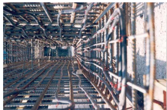
Abbildung 3: HDPE-Absorberleitungen einer „Energieschlitzwand“, montiert am Bewehrungskorb eines Schlitzwandelementes
