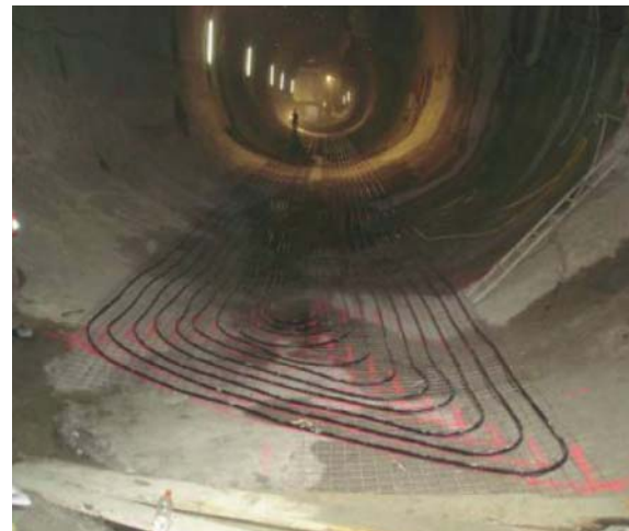
Abbildung 7: Energiebodenplatten in einem Stationsbauwerk (links) und in einem Tunnelabschnitt (rechts) bei der U-BahnLinie U2 in Wien.
