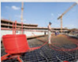
**3** Verlegen der Rohrleitungen nach Verlegeplan
