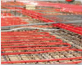
**4** Befestigung mittels Kabelbinder
