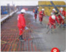
8 Betonieren des Bauteils unter Aufrechterhaltung des Drucks. Die Rohrleitungen dürfen bei den Betonierarbeiten nicht beschädigt werden.
