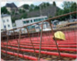
7 Komplettierung der Verlegearbeiten, Druckprobe der Rohrleitungen
