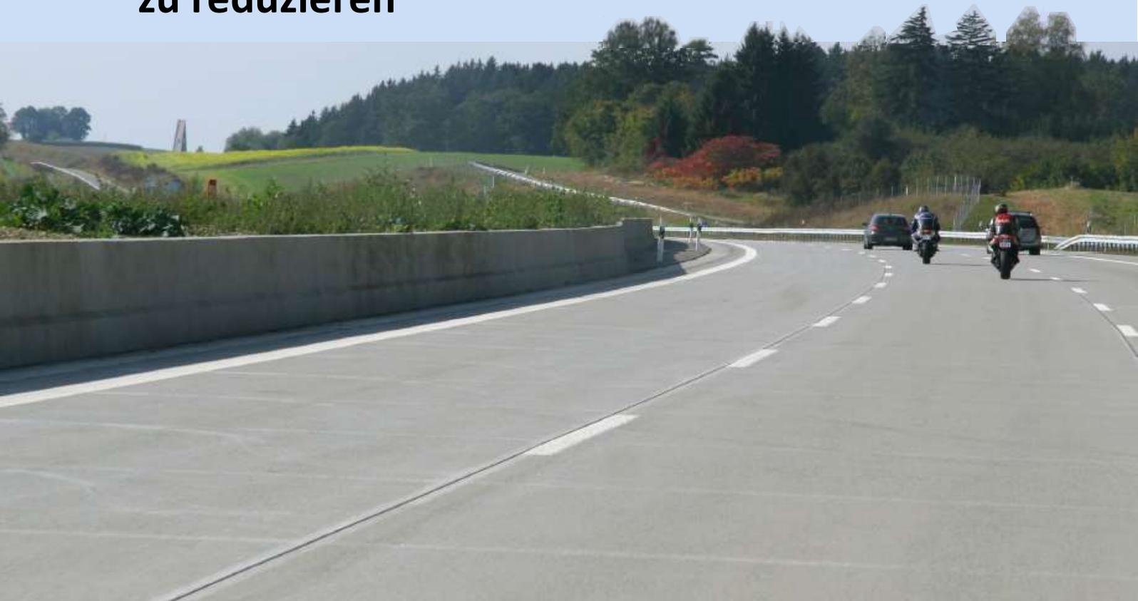
Die Albedo ist die Fähigkeit einer Oberfläche, Lichtstrahlen zu reflektieren. Bei einer hellen Betonoberfläche (hohe Albedo: 0,20 bis 0,40) wird mehr Energie in die Atmosphäre reflektiert als bei einer schwarzen Oberfläche (niedrige Albedo: 0,05 bis 0,15), die die Wärme absorbiert.
