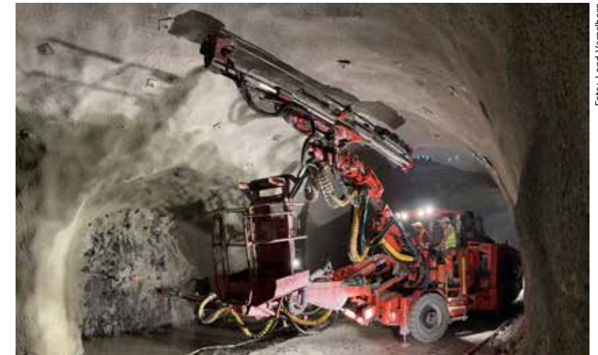
Tunnelbauarbeiten im Erkundungsstollen Tisis
