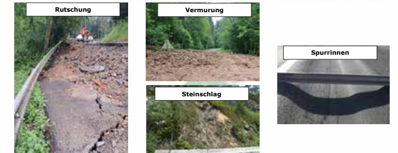
Unwetterschäden in der Steiermark machen bereits ein Achtel des Gesamtbudgets aus
