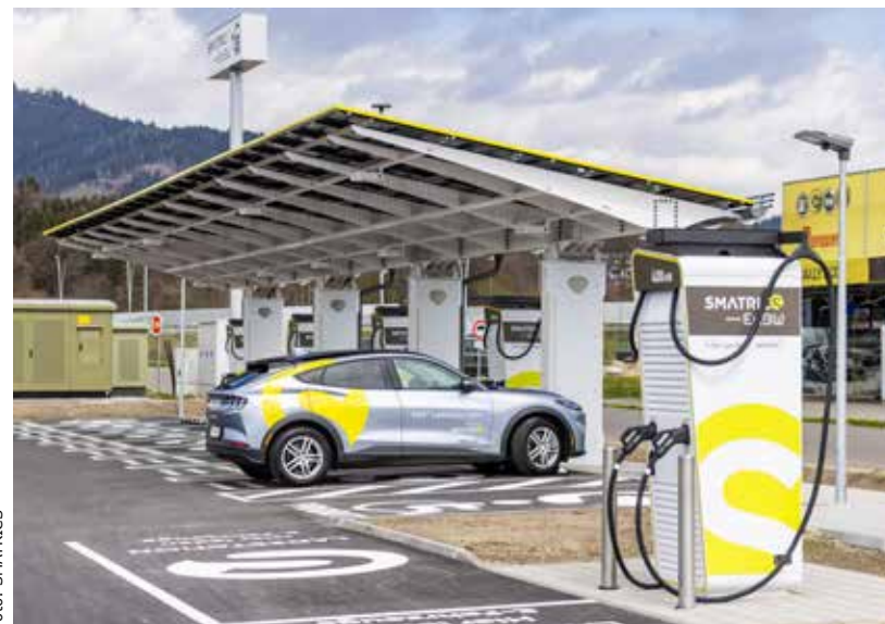
Beim neu errichteten Ladepark in Spielberg mit direkter Anbindung an die S36 stehen zwölf Ladepunkte mit einer Leistung von bis zu 400 kW zur Verfügung
