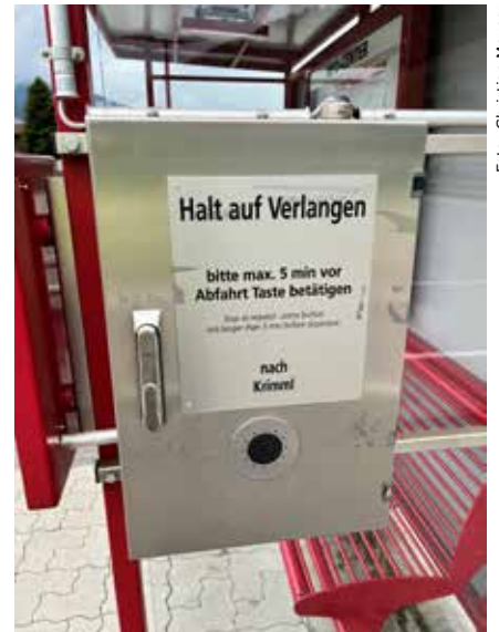
Zugleitsysteme geben Haltewünsche an den nächsten passenden Zug weiter
