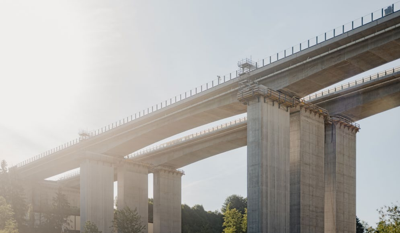
Die Aurachbrücke, mit 50 Metern die höchste Brücke der Westautobahn, wird bis Ende 2025 von der Arge Habau/Porr neu errichtet, Auftraggeber: Asfinag
