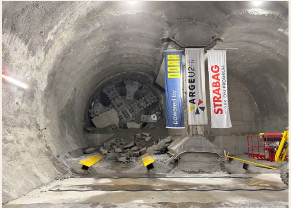
Durchbruch der Tunnelvortriebsmaschine am Augustinplatz
