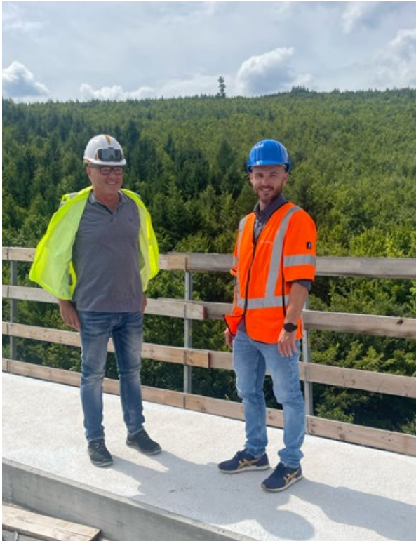
Thomas Veselsky, Tecton Consult Baumanagement, und Florian Klaus, Asfinag, zeigen stolz die Randbalken – bis zu 150 Meter wurden in einem betoniert.
