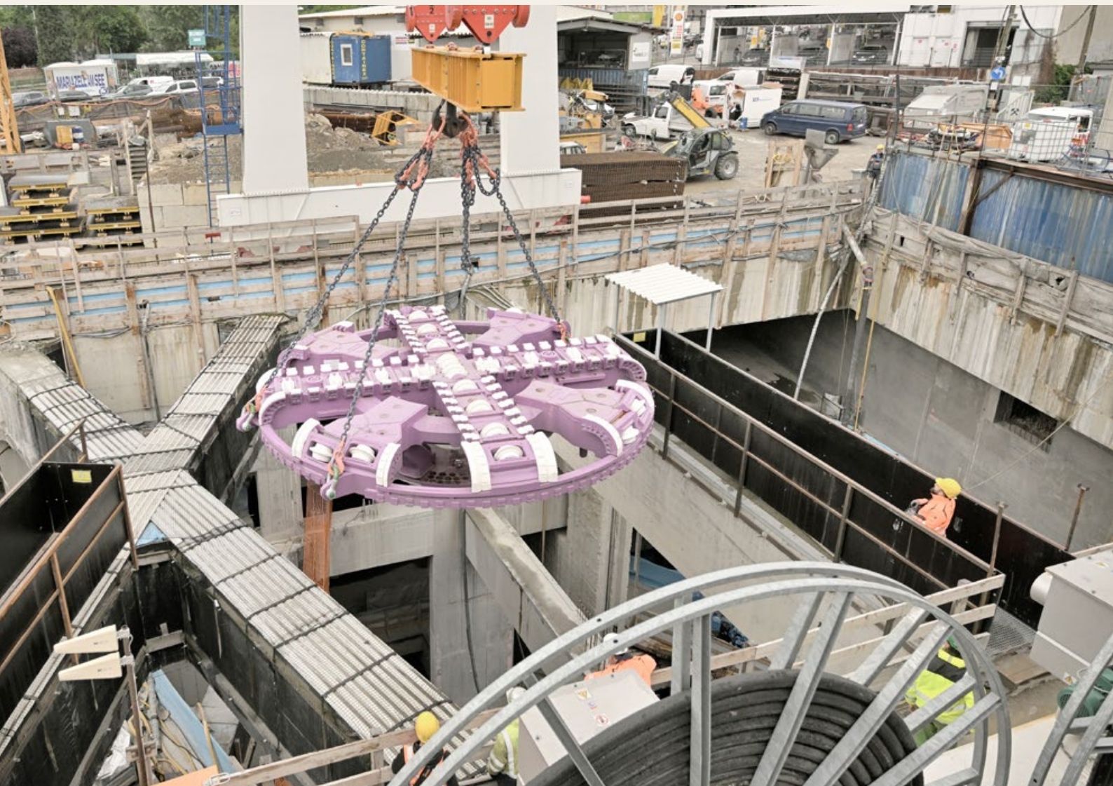
Der Einhub des Schneidrads, das Prunkstück der TVM, beim Matzleinsdorfer Platz. Es wiegt ca. 78 Tonnen, hat einen Durchmesser von 6,88 Meter und ist mit etwa 40 Rollmeisseln und 100 Schälmessern bestückt.
