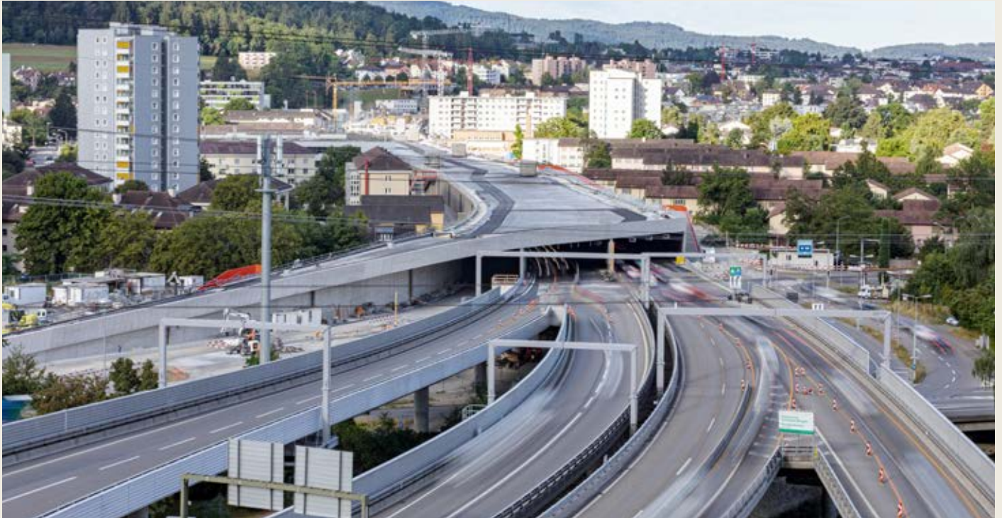
Spektakulär – mitten durch die Stadt: Die Einhausung Schwamendingen schirmt Lärm und Abgase von den Bewohnern perfekt ab.
