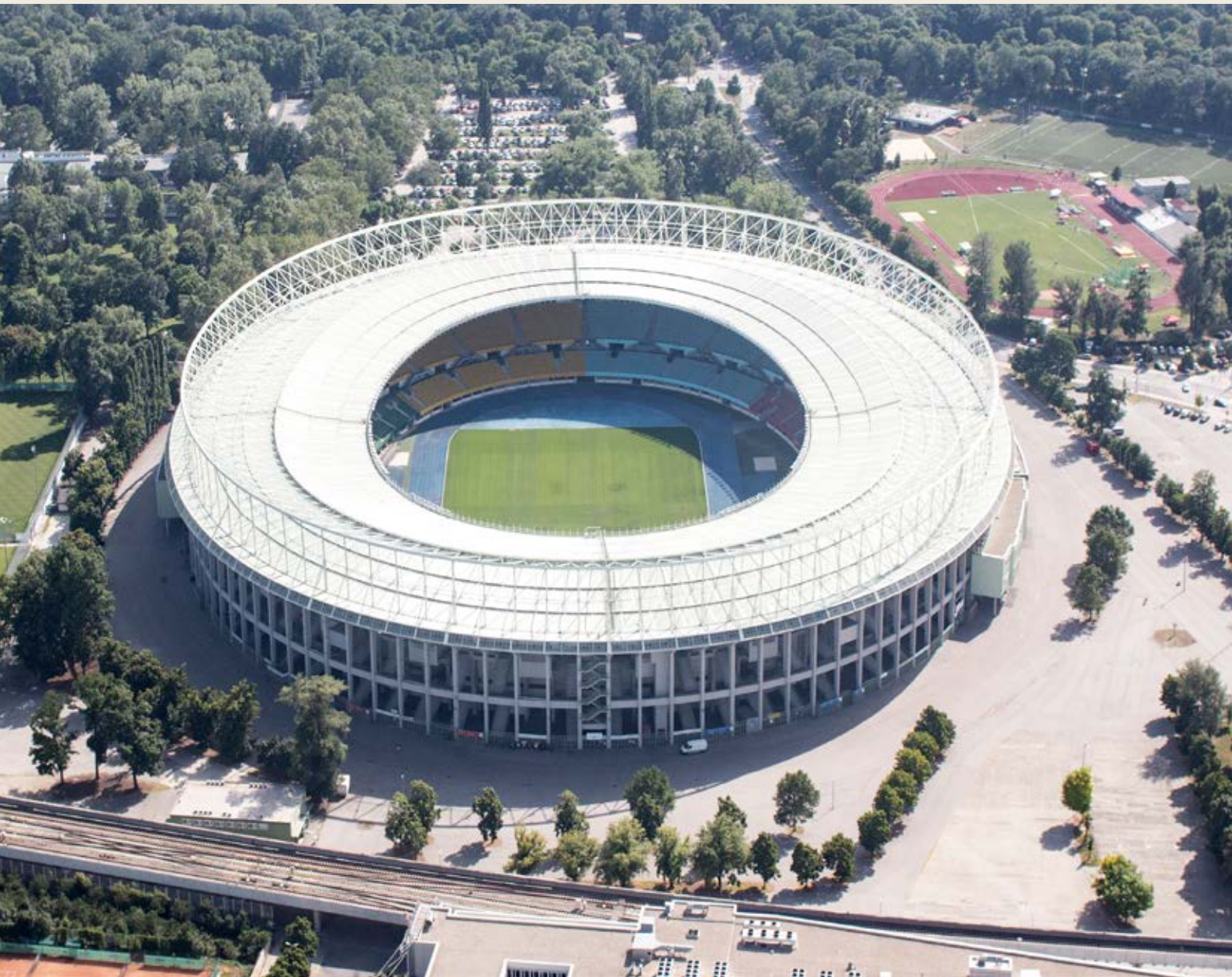
Das Wiener Praterstadion aus den 30er-Jahren gilt als beispielgebende Referenz für langwährende und nachhaltige Konzepte, geplant von Architekt Otto Ernst Schweizer – massiv gebaut aus Stahlbeton.
