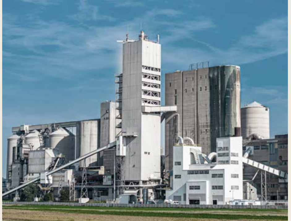
In Österreichs größtem Zementwerk, in Mannersdorf, ist die Errichtung und der Betrieb einer großindustriellen CO 2 -Abscheideanlage geplant.
