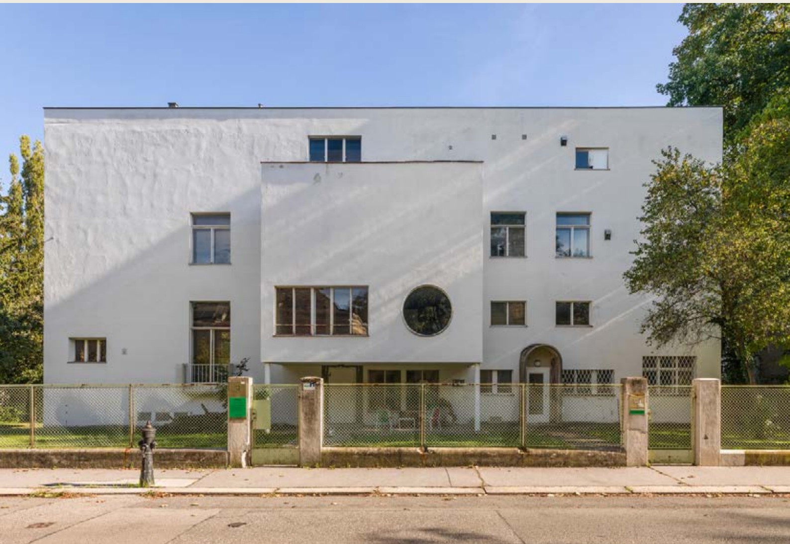
Die Villa Beer, ein denkmalgeschütztes Gebäude im 13. Bezirk in Wien, wird als Ort des kulturellen Lebens für die Öffentlichkeit renoviert.
