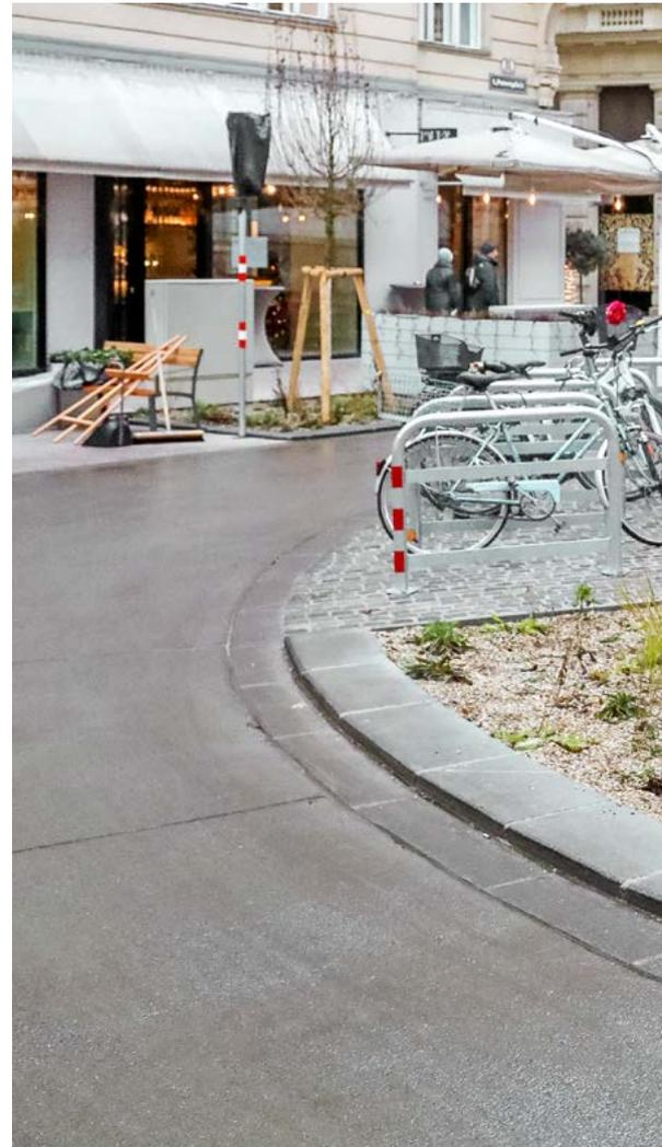
Helle Betonsteinpflasterung sorgt am Petersplatz in der Wiener Innenstadt dafür, dass sich die Oberfläche in den Sommermonaten nicht so stark erhitzt und Regenwasser versickern kann. Durch den Wasserrückhalt auf der Fläche wird die Kanalisation entlastet und das Mikroklima verbessert, da die Verdunstung besonders in der wärmeren Jahreszeit zu einer Temperaturreduktion führt.
