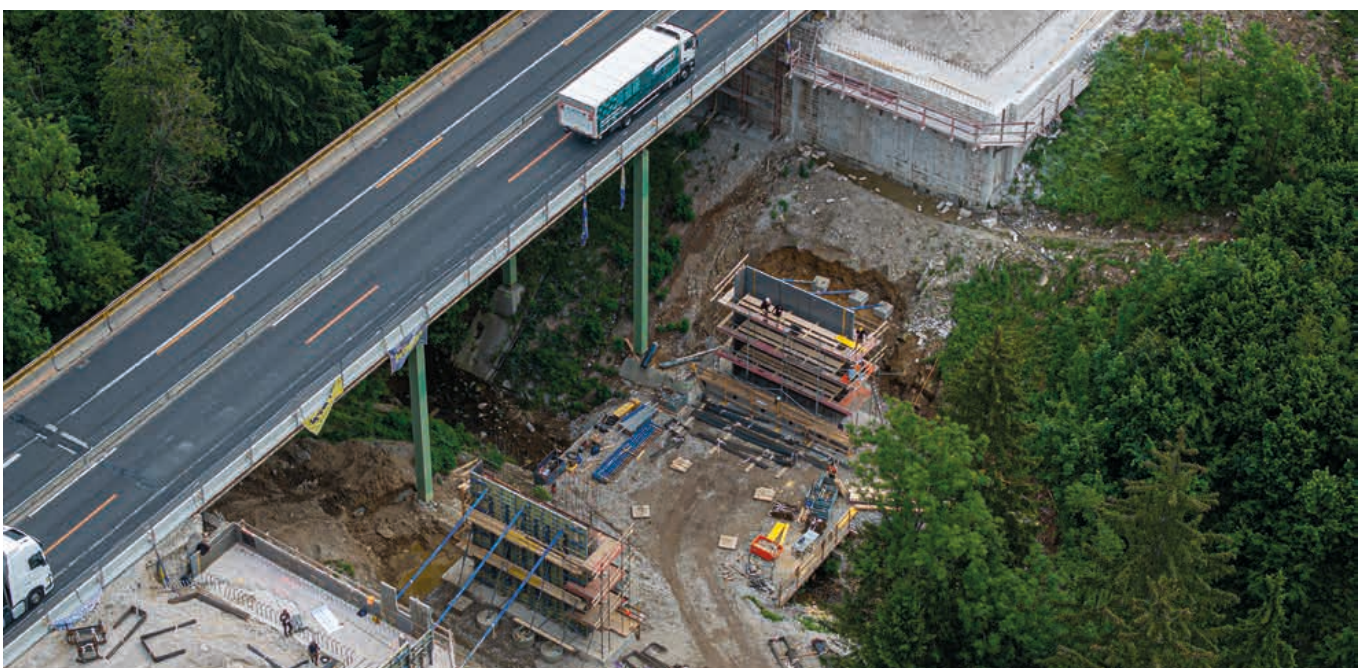
Die Brücke über den Ölgraben war Teil des 7,5 km langen Sanierungsabschnitts.
