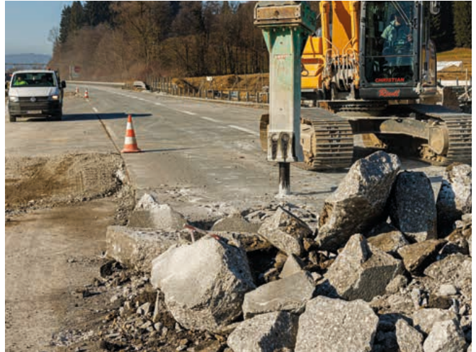
Schremmarbeiten auf einer Brücke
