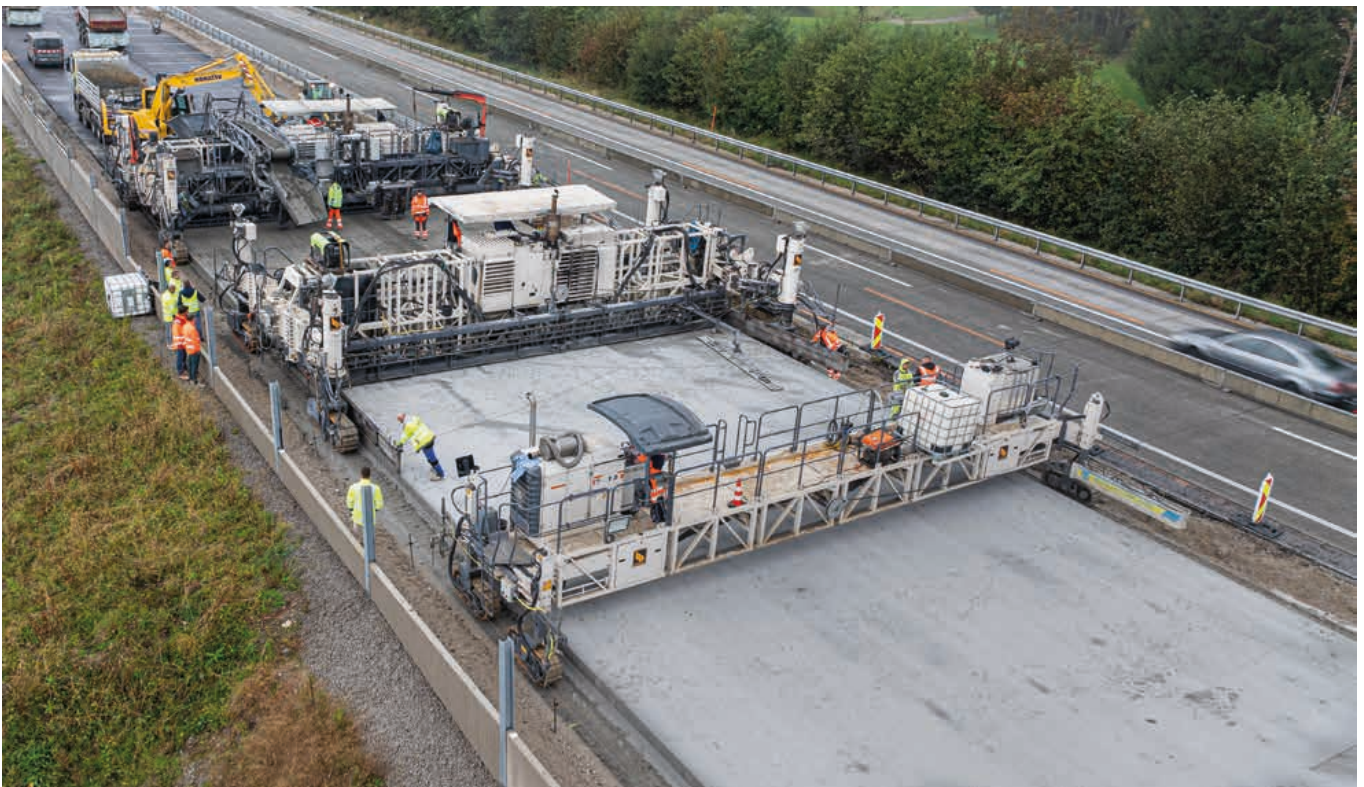
Gleitschalungsfertiger SP 1500 von Wirtgen: Der Unterbetonfertiger baut die untere Lage ein. Die obere Lage erstellt der Oberbetonfertiger «nass in nass».
