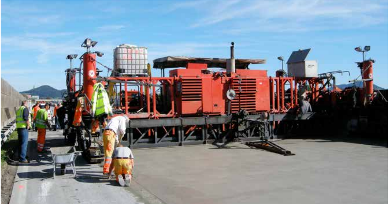
Abb. 7 Betondeckeneinbau am Tag
