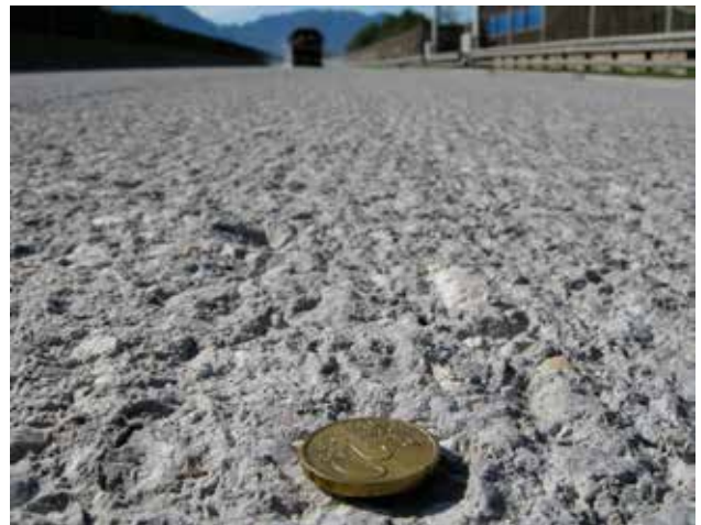
Abb. 5 Oberfläche nach der HDW-Reinigung
