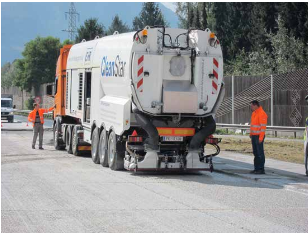
Abb. 6 Reinigung mittels Höchstdruckwasserstrahlen (HDW)
