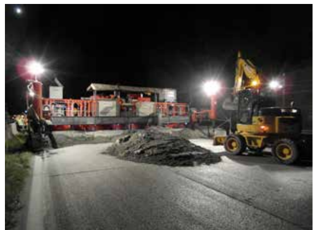
Abb. 8 Betondeckeneinbau in der Nacht
