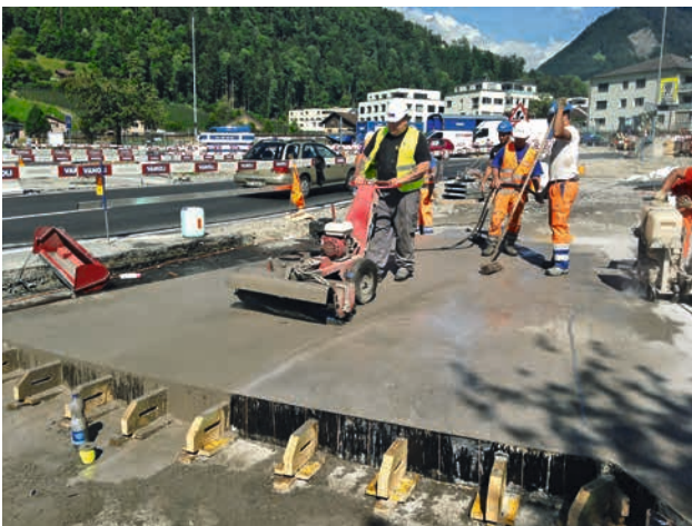
7. Ausbürsten der Betonoberfläche und erneutes Aufbringen des Verdunstungsschutzes (Curing)
