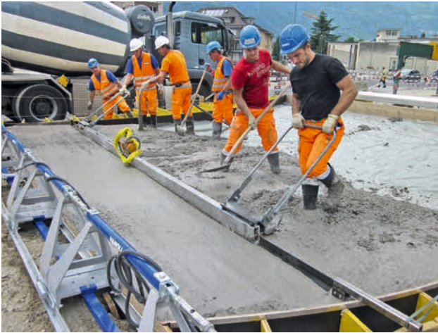
1. Einbringen des Unterbetons, d = 20\text{ cm}
