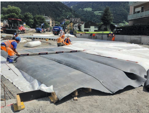
6. Abdecken und Schützen des Betons mit Vlies und/oder Matten
