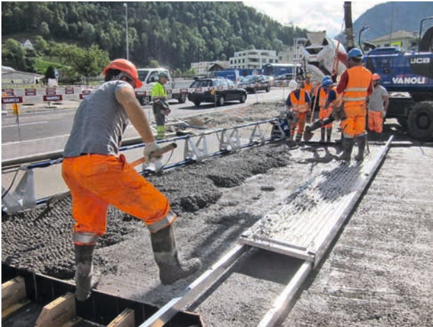
3. Einbringen des Oberbetons, d = 6 \text{ cm}
