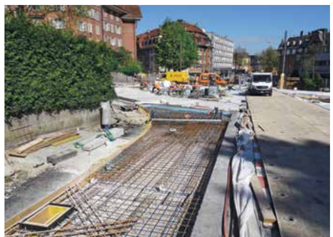
Betonierarbeiten der dritten Etappe.
