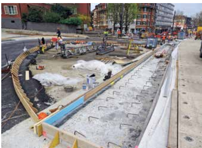
Betonieren der Randstreifen des Gleisbaus im Verbund.
