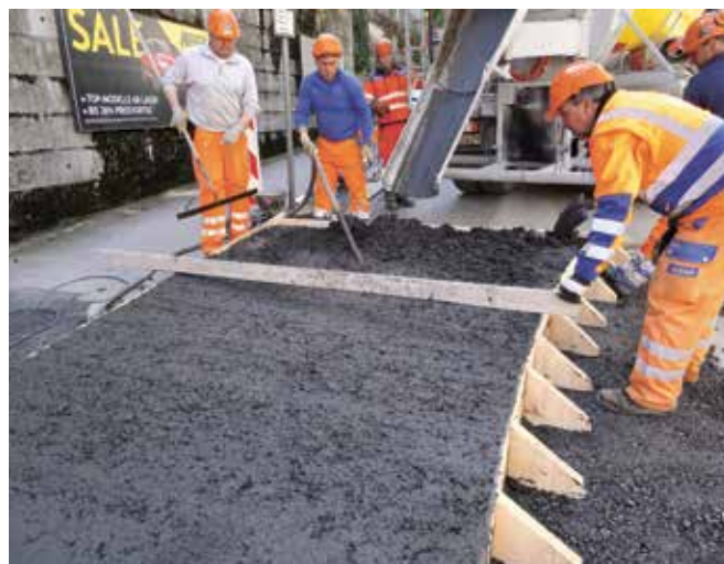
Einbringen des schwarz eingefärbten Betons.
