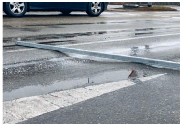
Verdrückungen im Asphalt aus Überlast durch Bremsen, Halten, Anfahren
