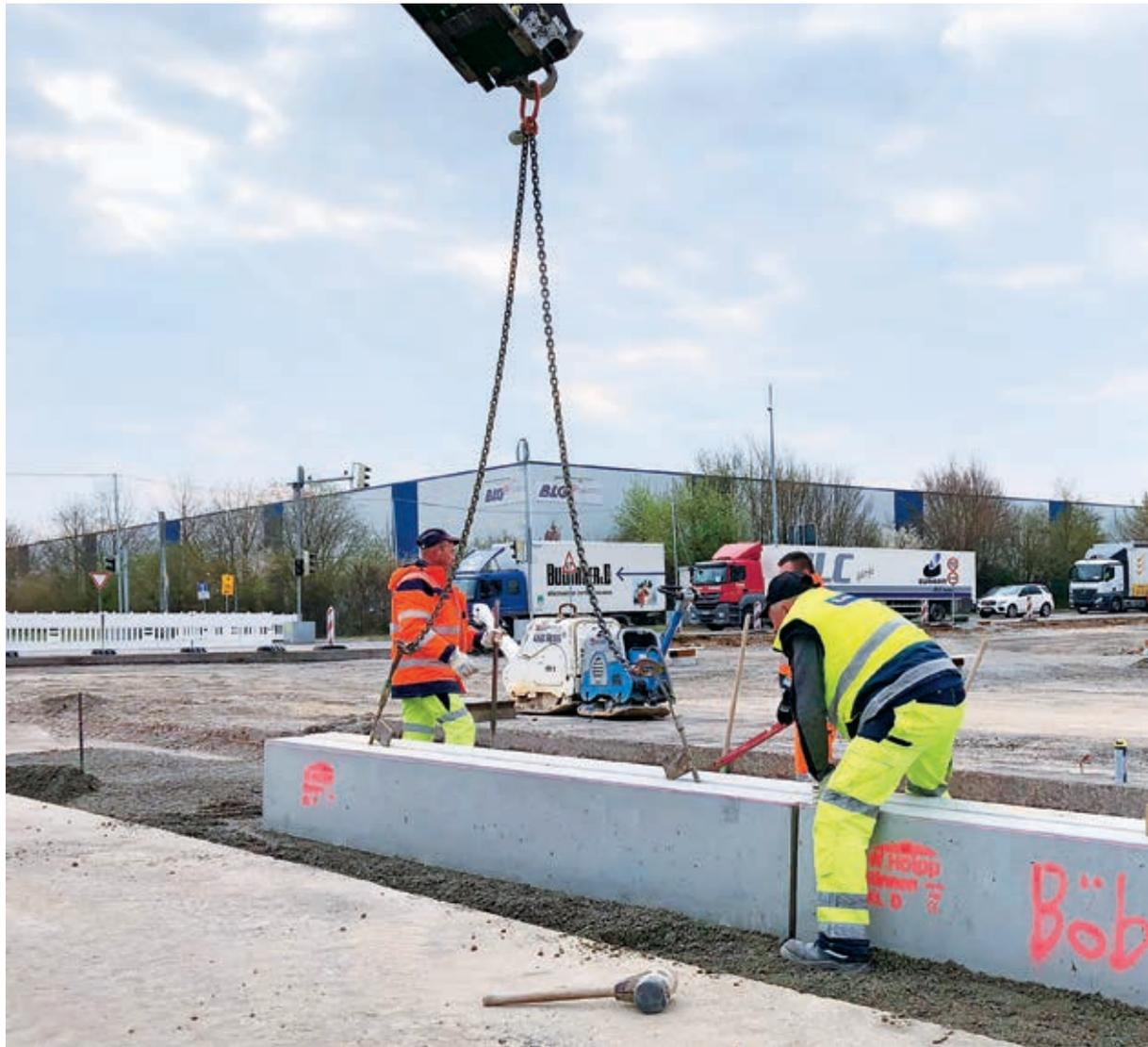
Tiefbauarbeiten, neue leistungsfähigere Straßenentwässerung
