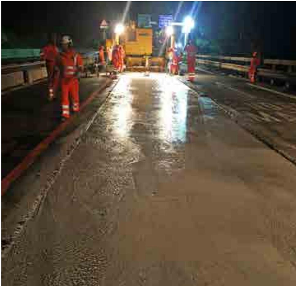
Active Crack Control und gleichmässige Rissverteilung
