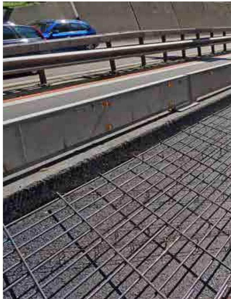
**«Mittlerweile ist dieses Teilstück in Kompositbauweise rund eineinhalb Jahre in Betrieb und unter Beobachtung durch die örtliche Bauleitung. Nach aktuellem Stand gibt es keinerlei Beanstandungen, weder Risse in der Deckschicht noch Vertikalversätze (Stufen) oder Blasenbildungen. Mit Stolz stellen wir fest, dass das durchlaufend bewehrte System wie geplant funktioniert.»**
