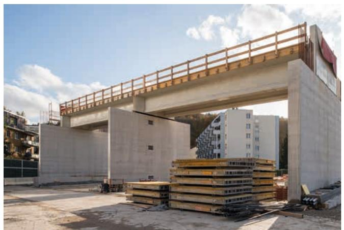
Auf dem Bild ist das Prinzip der aufliegenden vorgefertigten Querträger zu sehen, welche die Last der Einhausung tragen und die darunterliegende Infrastruktur, wie den Tramtunnel, nicht belasten.
