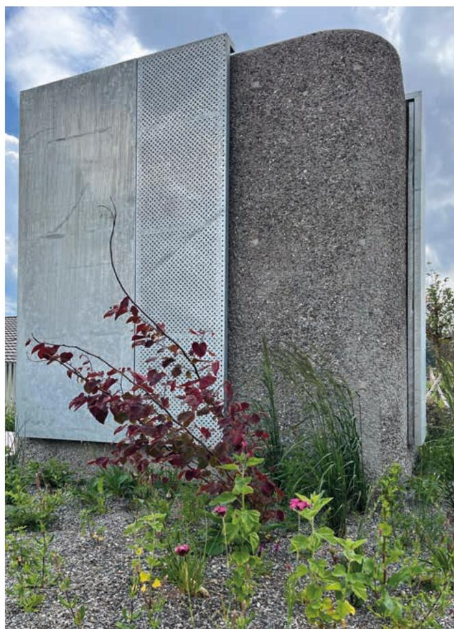
Ereignislüftungen der Einhausung Schwamendingen wurden zusammen mit anderen Sicherheitssystemen ausgiebigen Tests unterzogen und führen bei einem Ereignis entstehenden Rauch ab. Bild: Bundesamt für Strassen ASTRA
