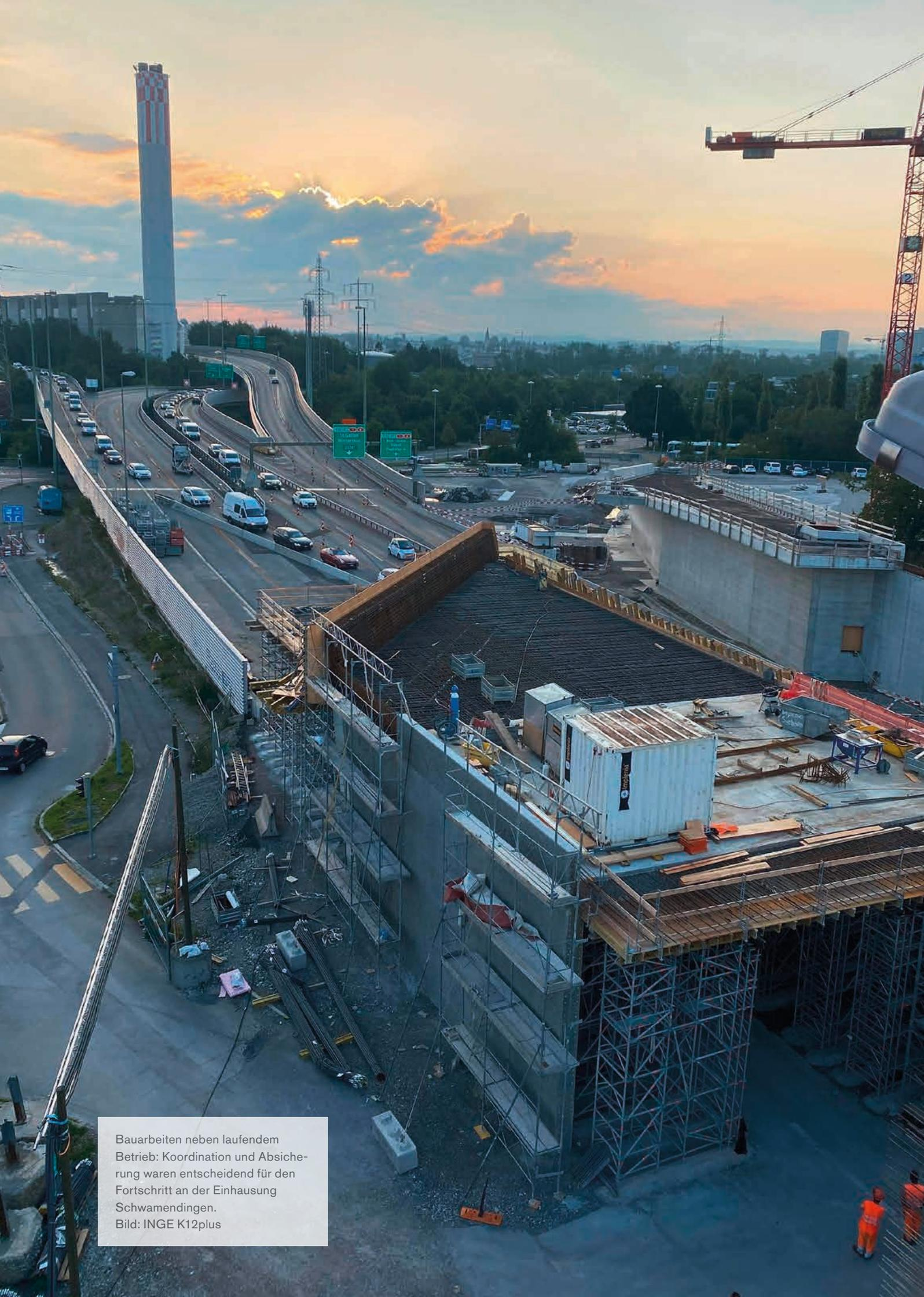
Bauarbeiten neben laufendem Betrieb: Koordination und Absicherung waren entscheidend für den Fortschritt an der Einhausung Schwamendingen.
