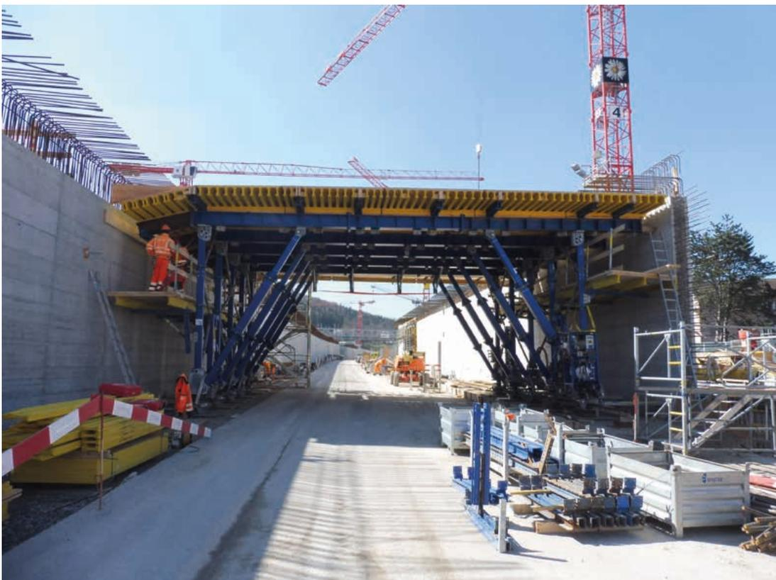
Der Schalwagen ermöglichte die effiziente Herstellung der Deckenelemente auf einer Arbeitsplattform in sechs Metern Höhe. Er bot Sicherheit und Flexibilität durch hydraulisch anpassbare Teleskopstützen. Bild: INGE K12plus
