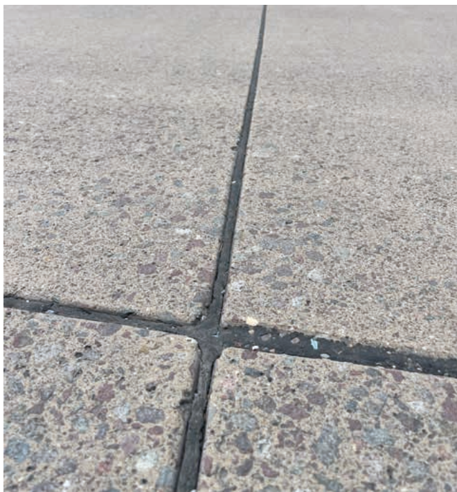
Flächengestockte Oberfläche mit heiß verfülltem Scheinfugenkreuz und sichtbarer WS-Gesteinskörnung
