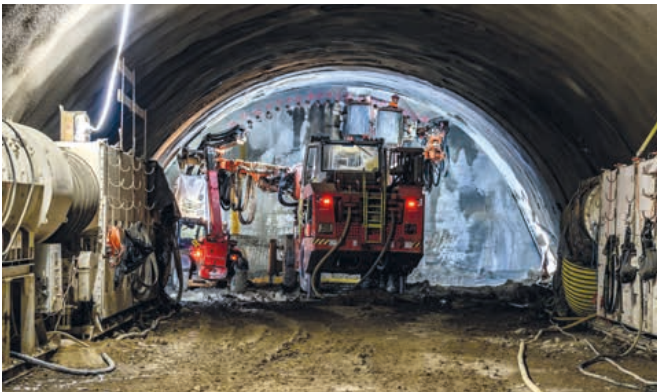
Erstellung der Bohrungen für den Rohrschirm
