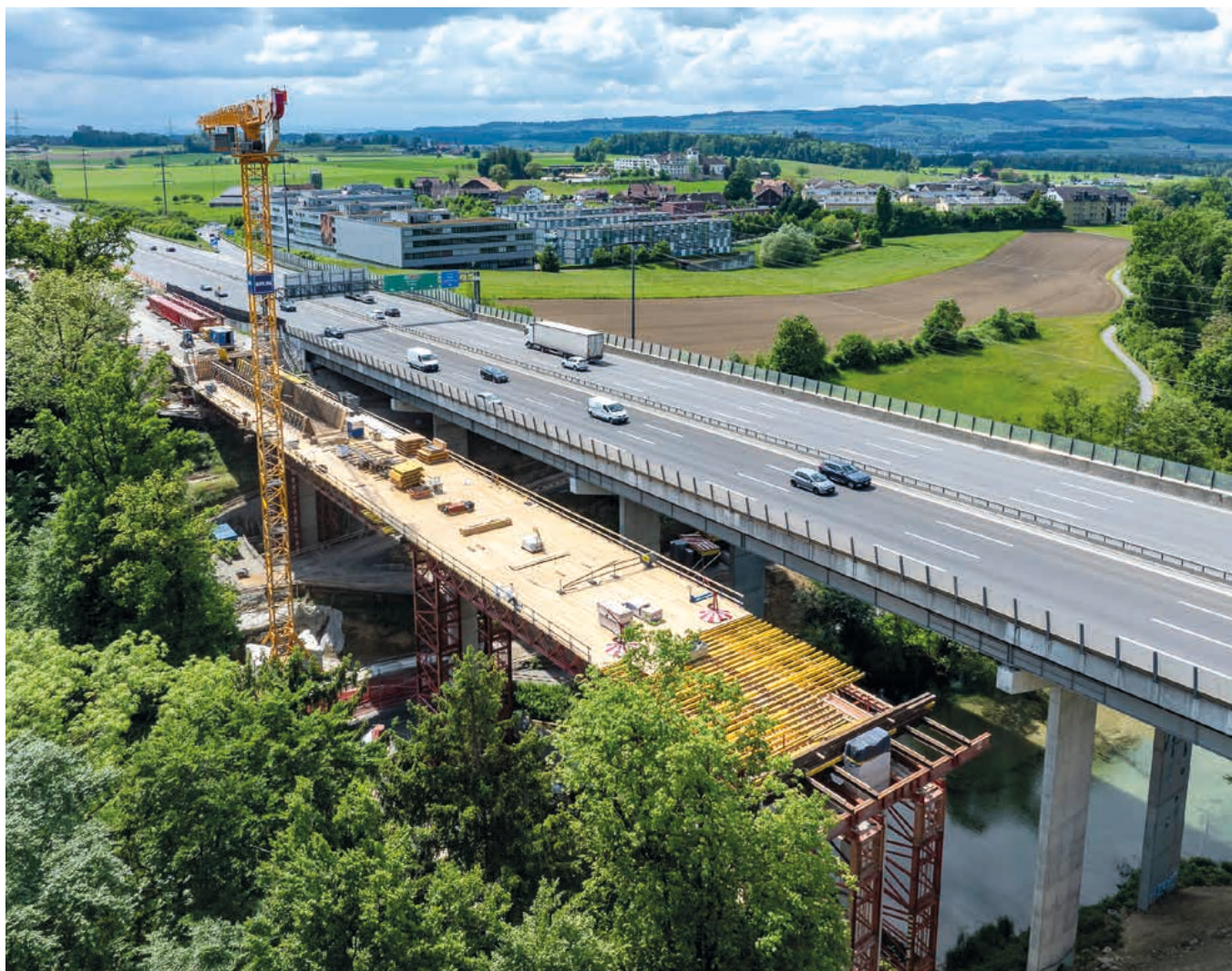
Vorbereitung der Armierungen und Schalungen für den V-förmigen Hohlkasten
