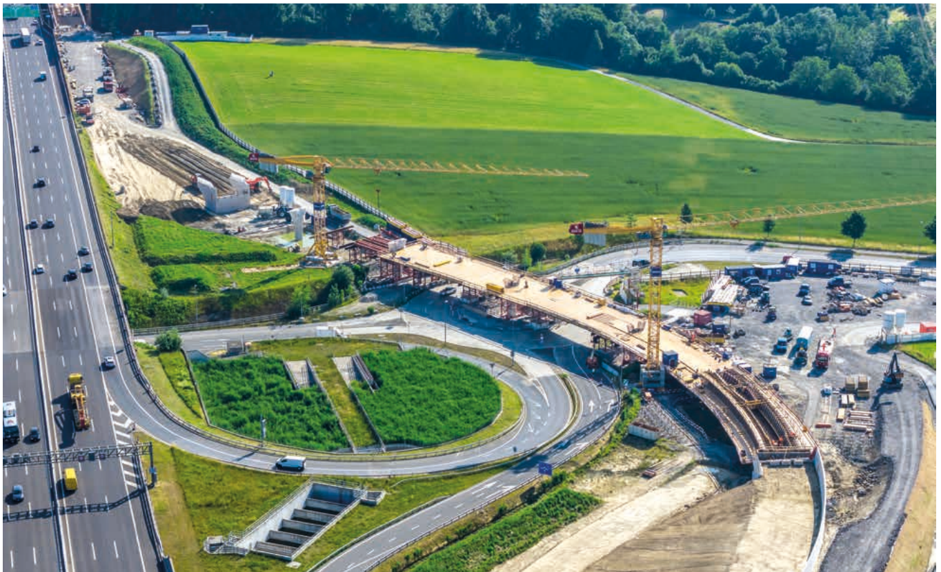
Die Brücke Gibelfeld ist S-förmig und überquert in rund sechs Metern Höhe einen Kreislauf. Ein Pfeiler befindet sich in der Mitte des Kreislaufs.
