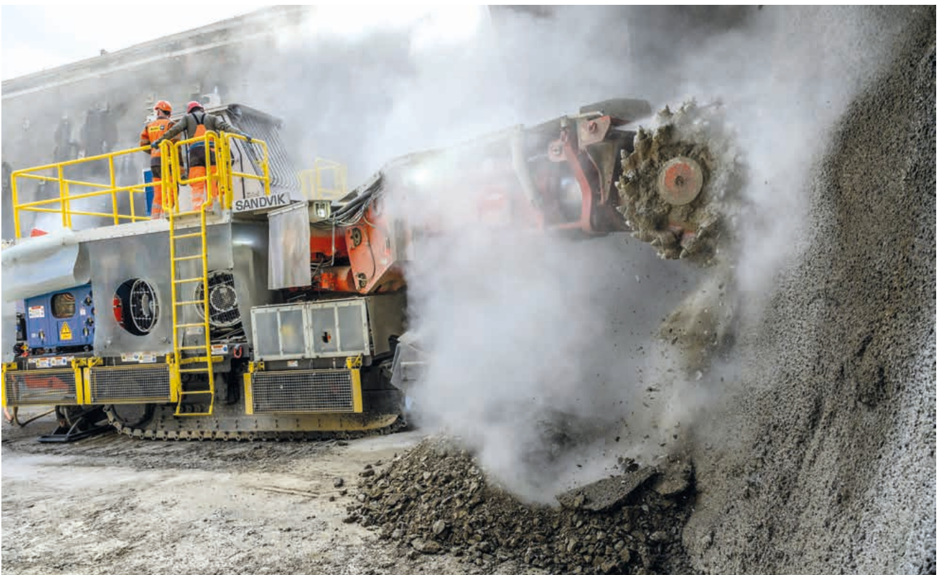
Die für den Ausbruch des Tunnels Städtlerwald eingesetzte, elektrische Teilschnittmaschine wiegt 135 Tonnen und lässt sich von einem einzigen Maschinenföhrer bedienen.
