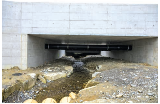
Der Kleintierdurchlass Wasenbächli
