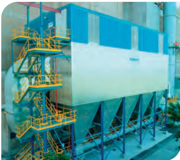
Damit auch kein Staub aus dem Kamin herauskommt, muss das Abgas vorher noch durch eine Tuchfilteranlage → G. Diese funktioniert wie ein Staubsauger, ist allerdings so groß wie ein Einfamilienhaus. Auch die heiße Luft, die nach der Kühlung des Klinkers den Klinkerkühler verlässt, wird wiederverwendet. Sie dient zum Teil als Verbrennungsluft im Drehrohfen und zum Teil zur Heißwassererzeugung in der Wärmerückgewinnungsanlage.
