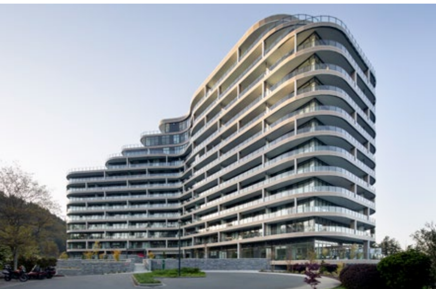
Aus einer ehemaligen Bau ruine wurde ein Wohnbau – die Tragstruktur aus Beton blieb erhalten.
