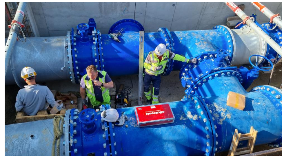
Neubau einer Kammer für die 4. Hauptleitung im Süden von Wien
