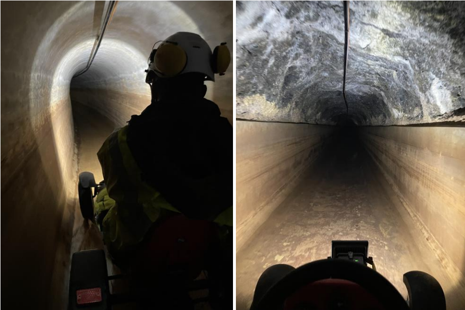
Stollenbefahrung I. Hochquellenleitung
