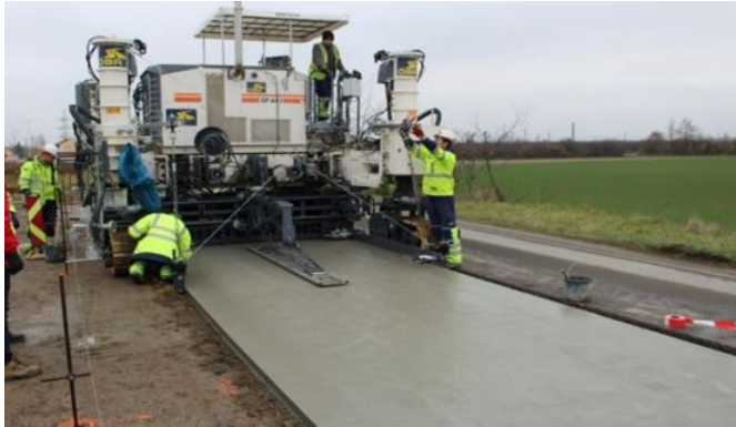
Abbildung 1: Einbau von White Topping mit Betondeckenfertiger
