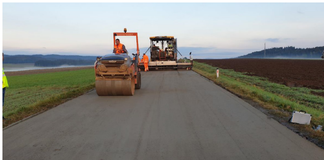
Abbildung 2: Herstellung von Walzbeton auf einem Straßenabschnitt
