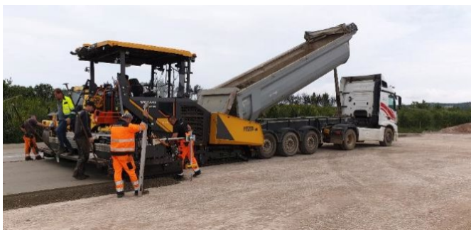
Abbildung 2: Herstellung von Walzbeton auf einer Industriefläche
