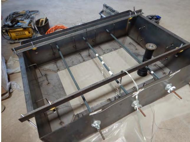
Abb. 2: Zur Betonage vorbereitete Schalung der Großkörper
