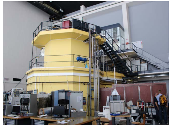
Abb. 2: Fertiggestellte Strahlenkammer (rechts) im typischem „Hämatit-rot“ des Schwerbetons
