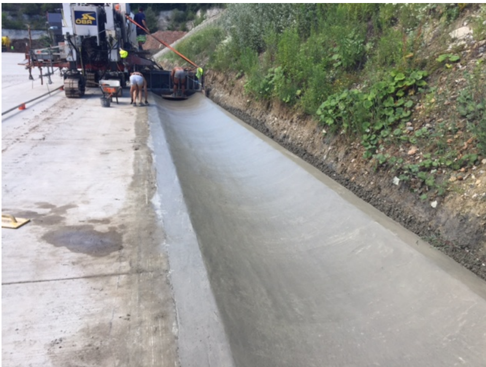
Abbildung 4: Herstellen der Mulde
