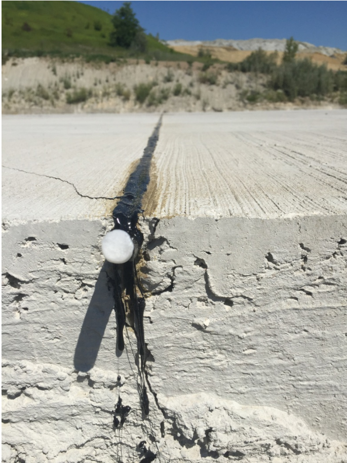
Abbildung 6: Dauerelastische Fugenabdichtung
