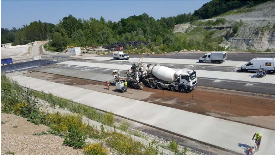
Abbildung 3: Einbau in Linien mit einer Breite von 5 m im Pilgerschrittverfahren
