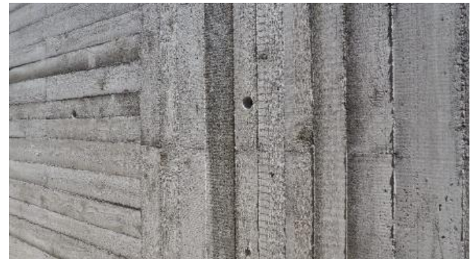
Musterfläche Baufirma Schütz
