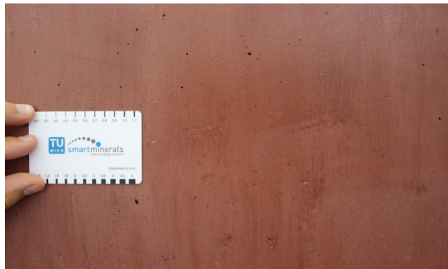
Abb. 3: Oberfläche der Fertigteile nach Montage am ATI
