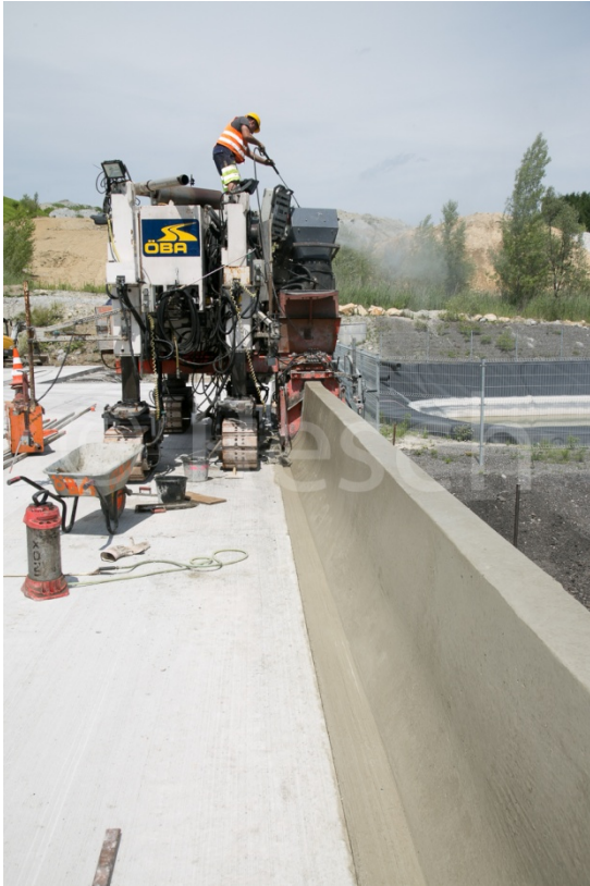
Abbildung 5: Herstellen der Absturzsicherung (Jersey-Wand)
