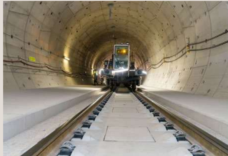
Perfekt betoniert: Der Koralmtunnel ist eine technische und logistische Höchstleistung.
