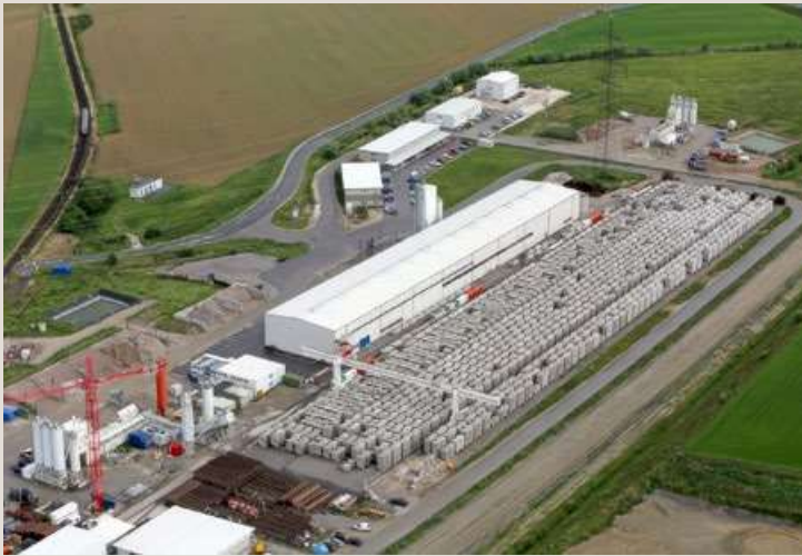
In der Feldfabrik wurden 43.429 Tübbinge sowie 5.000 Sohlelemente für den rund 10,5 Kilometer langen Tunnelabschnitt hergestellt.
