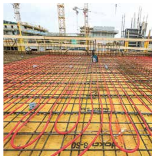
Verlegung der thermischen Bauteilaktivierung auf der Baustelle in der Käthe-Dorsch-Gasse.
