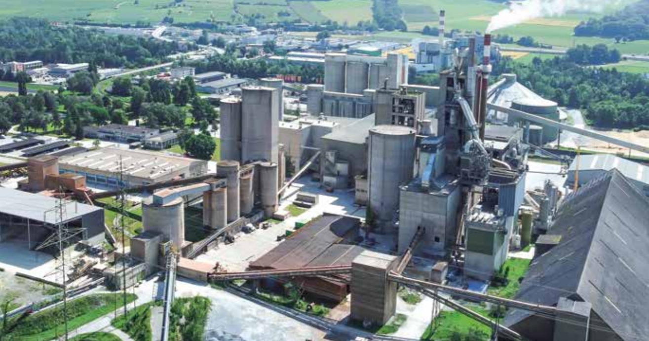
Zement aus dem Rheintal: Holcim produziert im Werk Untervaz (CH) nahe Chur und will noch gezielter Ersatzrohstoffe und Ersatzbrennstoffe nutzen.
