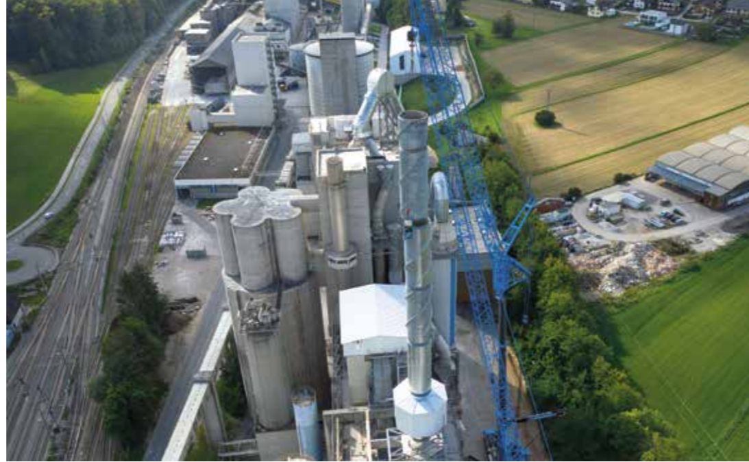
Neben der modernen Schlauchfilteranlage wird im Zementwerk Hatschek in Gmunden zukünftig auch die Pilotanlage zur CO 2 -Abscheidung Platz finden.
