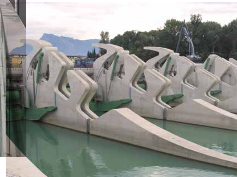
Kraftwerk Sohlstufe Lehen, Salzach
