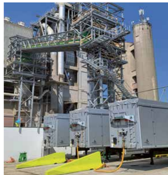
Auf direktem Weg: Im neuen Ladeterminal „EBS 5“ von Kirchdorfer gehen die Ersatzbrennstoff-Lieferungen vom Anhänger direkt zur Ofenanlage.
