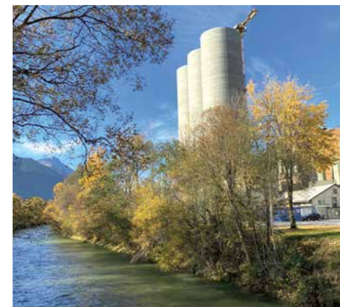
Die zusätzliche Mahl- und Lagerkapazität in Vils, vor allem die drei neuen Silos, ermöglicht eine effiziente Produktion von Bindemitteln und lässt den innerbetrieblichen Verkehr nach und von Kirchbichl entfallen.
