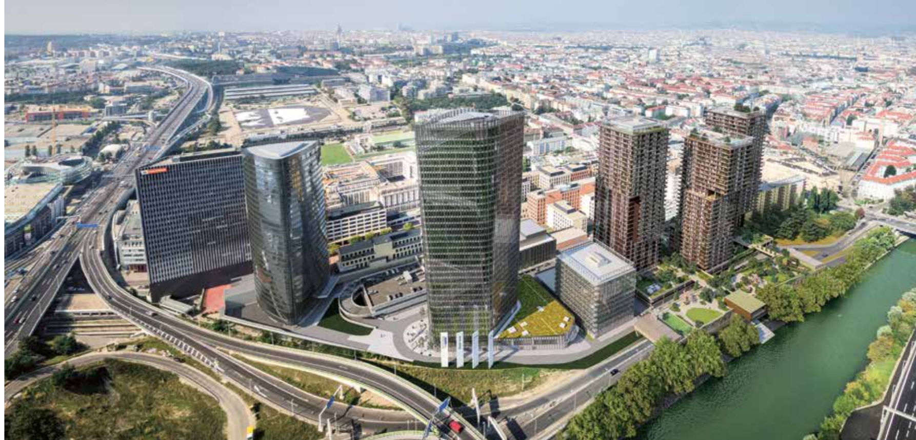
Klimafittes Hochhaus: Der bauteilaktivierte Austro Tower (Mitte) sorgt für Wohlfühlklima in allen 36 Stockwerken, wird mit Wasser aus dem Donaukanal gekühlt und schont die wertvolle Ressource Boden.
