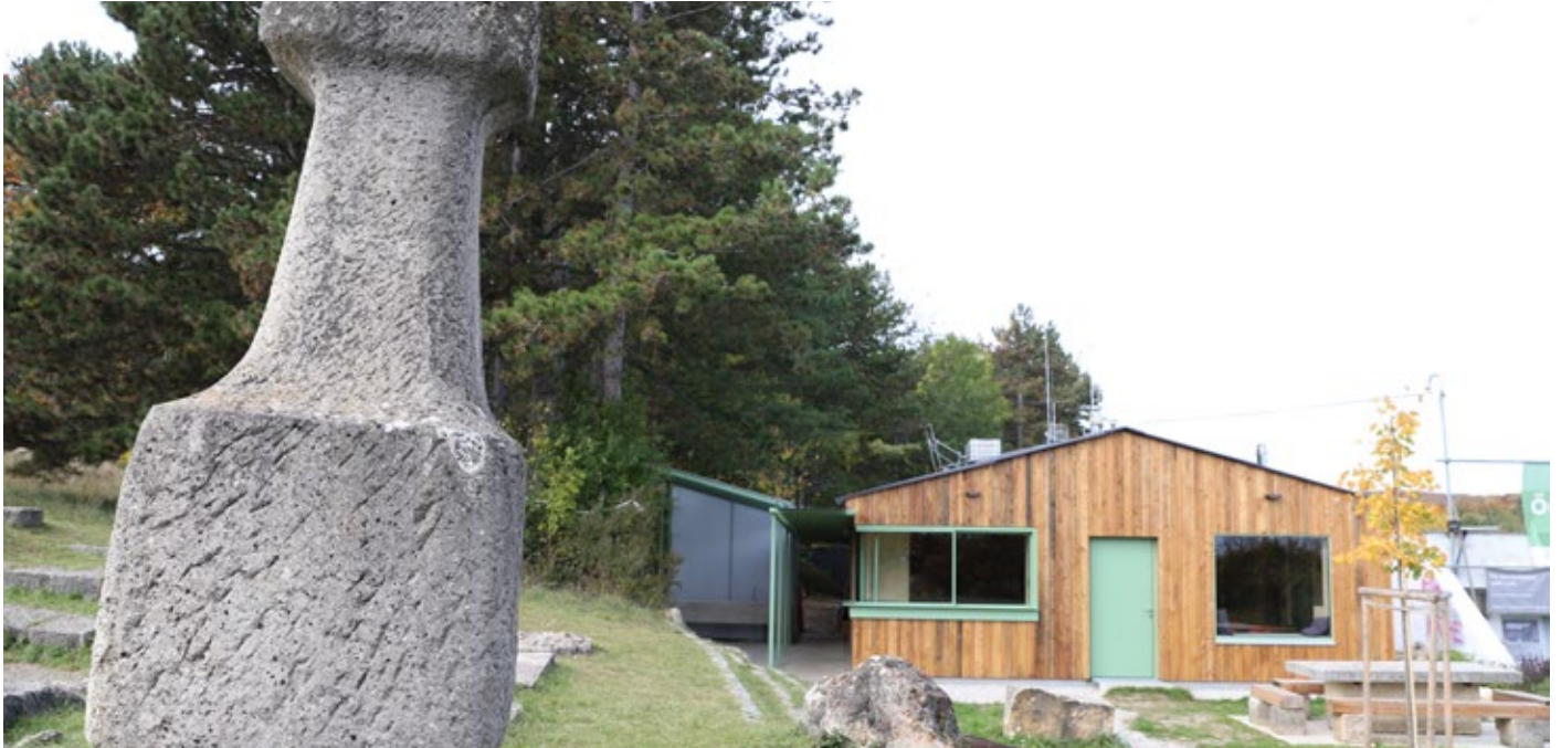
Nach einer fünfmonatigen Planungs- und siebenmonatigen Bauphase steht das adaptierte Vereinshaus auf stabilen Fundamenten nun wieder zur vielseitigen Nutzung bereit.
