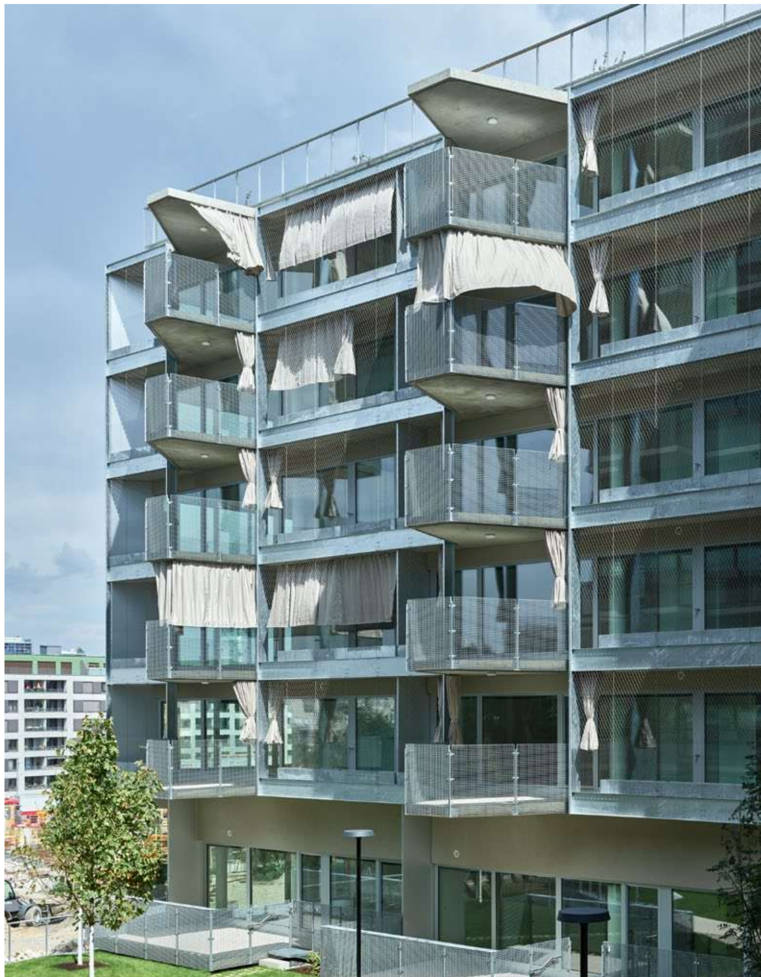
Bauteil von Artec Architekten
