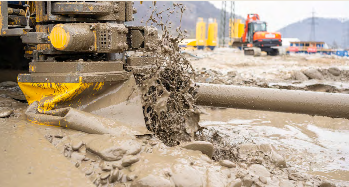
Bodenverbesserungsmaßnahmen mit Soilcrete® zählen zu den wirtschaftlichsten und vielseitigsten Verfahren zur Verfestigung und Abdichtung des Baugrunds – erstmals wurde CEM II/C verwendet.
