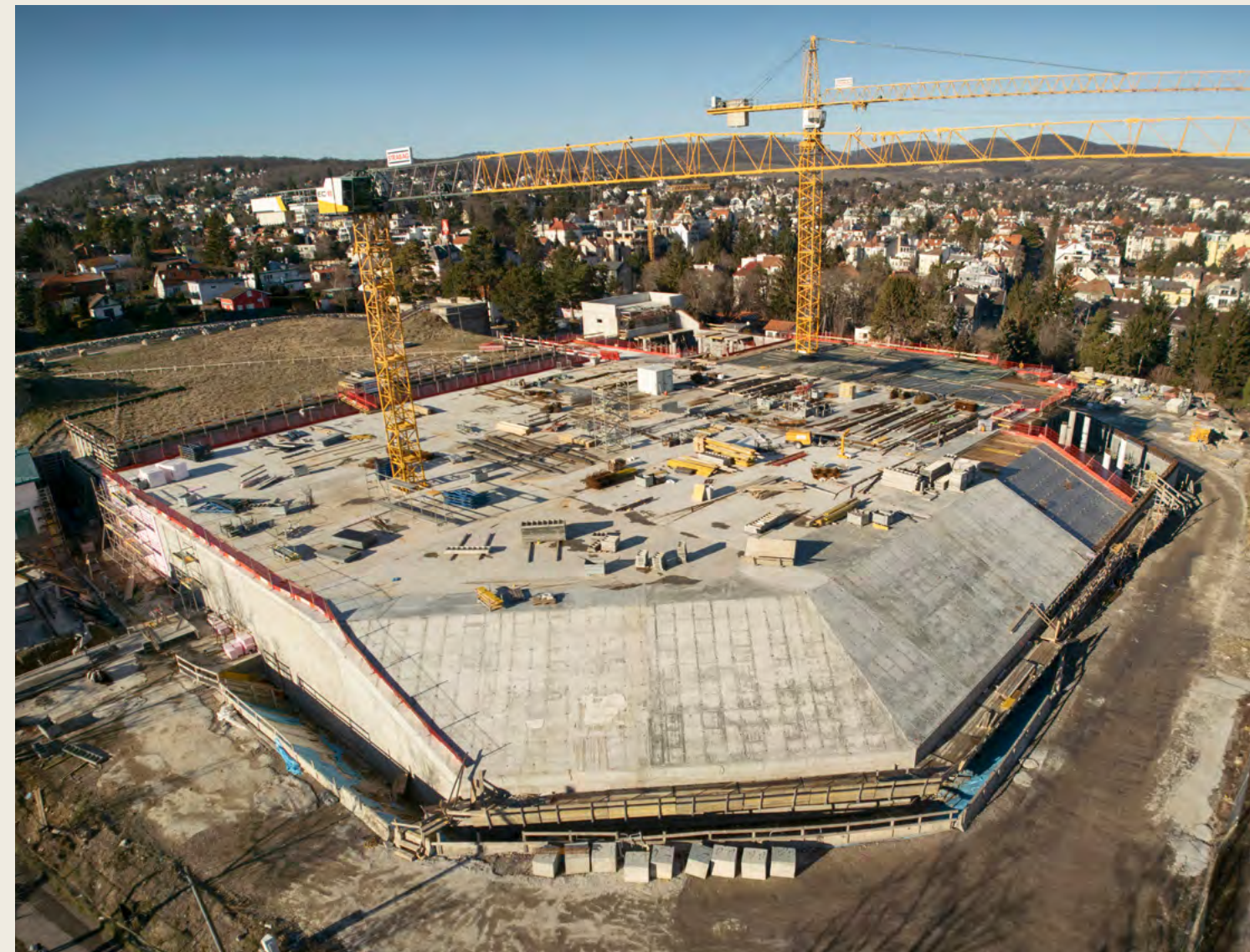
Durch die abgeschrägte Decke konnte im Vergleich zu vertikalen Wänden 20 bis 25 Prozent mehr Volumen auf der gleichen Grundrissebene generiert werden.
