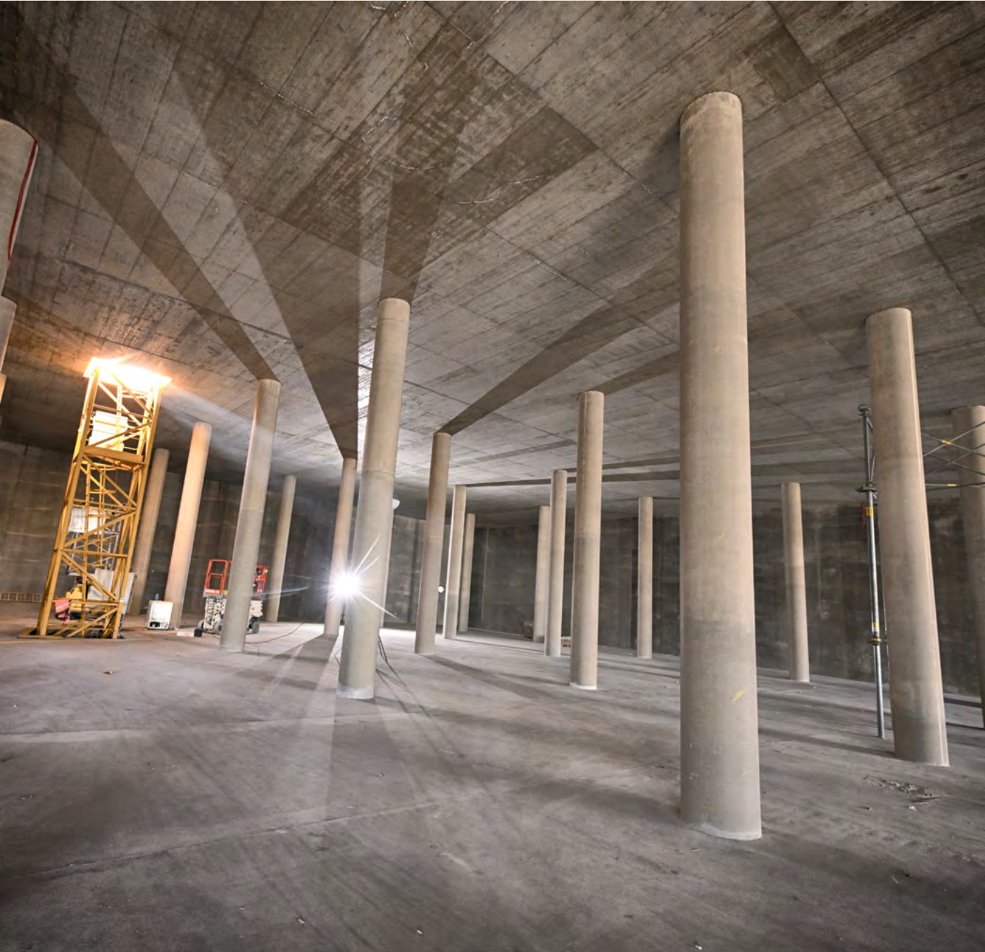
Erstmals wurden runde Säulen aus Ort beton verwendet, da sie im Gegensatz zu eckigen Säulen für einen besseren Durchfluss sorgen.
