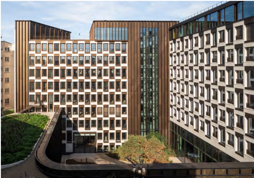
Die alte Betonstruktur wurde freigelegt und konnte erhalten werden.
