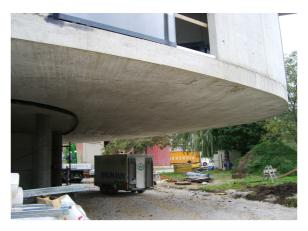
Neubau Bürohaus der Kirchdorfer Zementwerke, Deckenstärke 40cm, Auskragungen in Teilbereichen bis zu 8,50m, schlaff bewehrt, Betonkernaktivierung in Decken eingebaut
