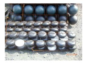
Gewichtsreduktionen von 1,30 bis zu 4,77 KN / m2 belegter Fläche sind möglich (ca. -20 bis ca. -35%)
