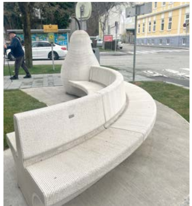
Die 3-D-gedruckte Bank aus Beton lädt zum Verweilen und als Treffpunkt ein.
