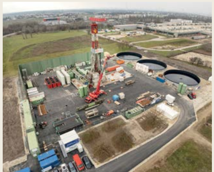
Die Fördertestbecken sind bereits fertiggestellt.
