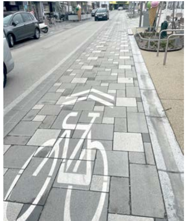
Der Radweg ist in der einspurigen Straße rund um den Hauptplatz integriert – und doch separat.
