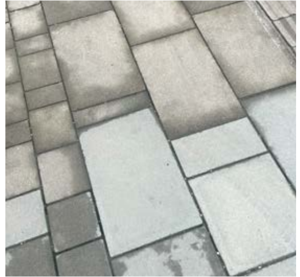
Das Amstettner Pflaster – oben die alten Steine, die wiederverwendet wurden, unten die neuen Betonsteine – darunter befindet sich Niederösterreichs größtes Schwammstadtprojekt.
