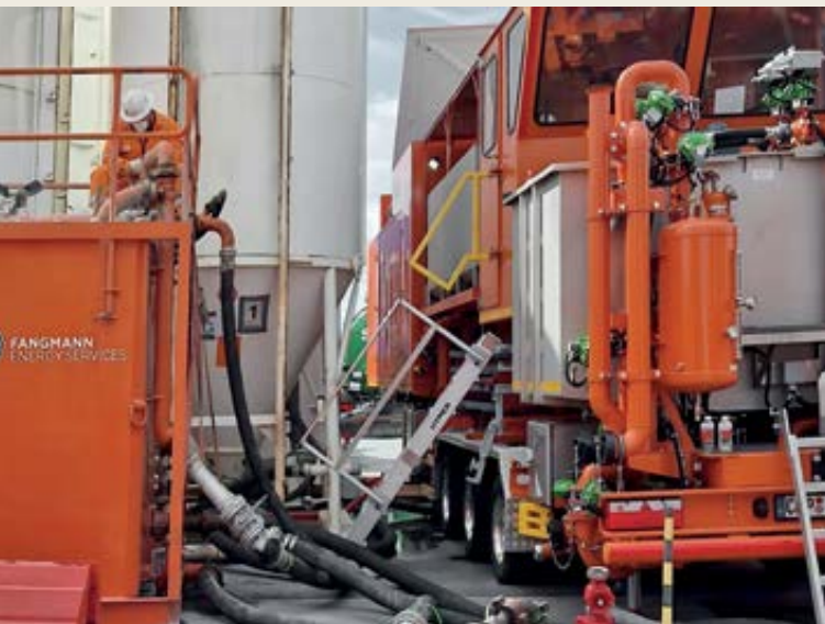
Mit einem Spezialzement werden die Bohrlöcher stabilisiert.
