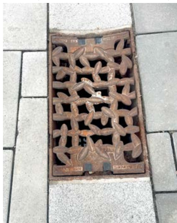
Das Einlassgitter mit Blättermuster weist darauf hin, dass hier das Wasser für die Bewässerung der Bäume abrinnt bzw. für die Entlastung des Kanals sorgt.
